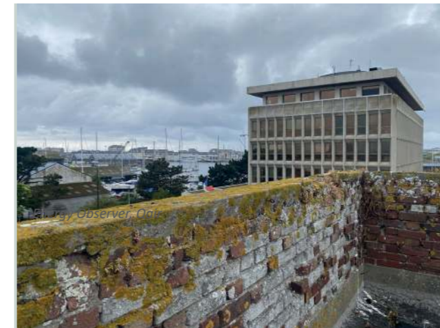
Vue du port depuis le toit
