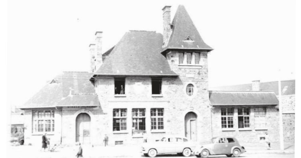
Poste de Rocabey
